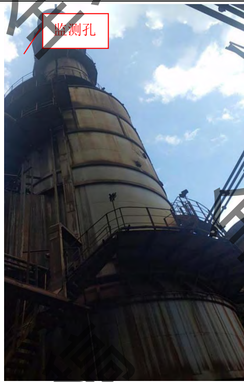
DA0192#粗炼废气排放口(经度: 119°44'21.577' 纬度: 26°46'11.600'高度: 60m, 内径: 4.5m 出 口温度: 55℃)
